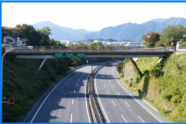
市道中央通り線 鳥居の前第2橋
