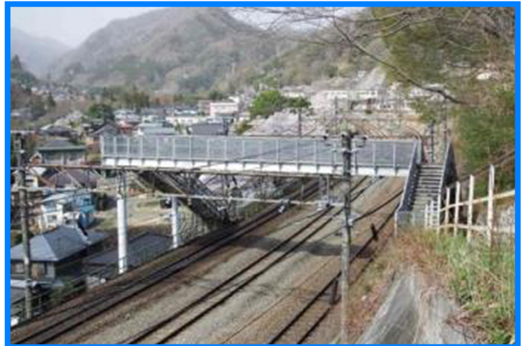
市道奥平東線 奥平陸橋
