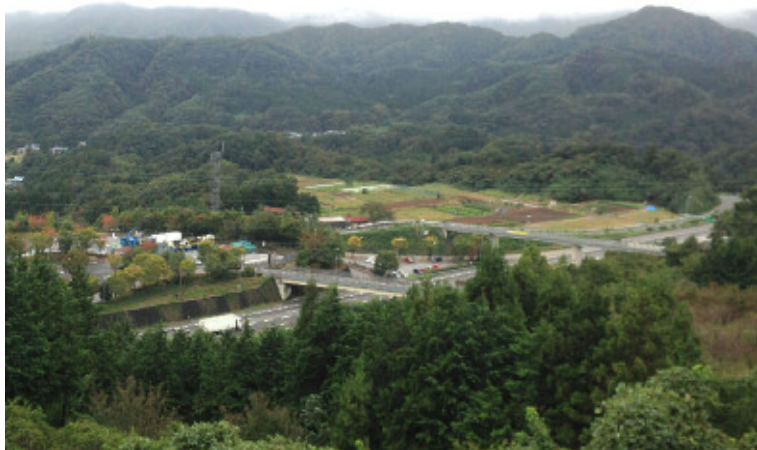
• ②高速道路軸の例：(仮称) 談合坂スマートIC建設予定地
