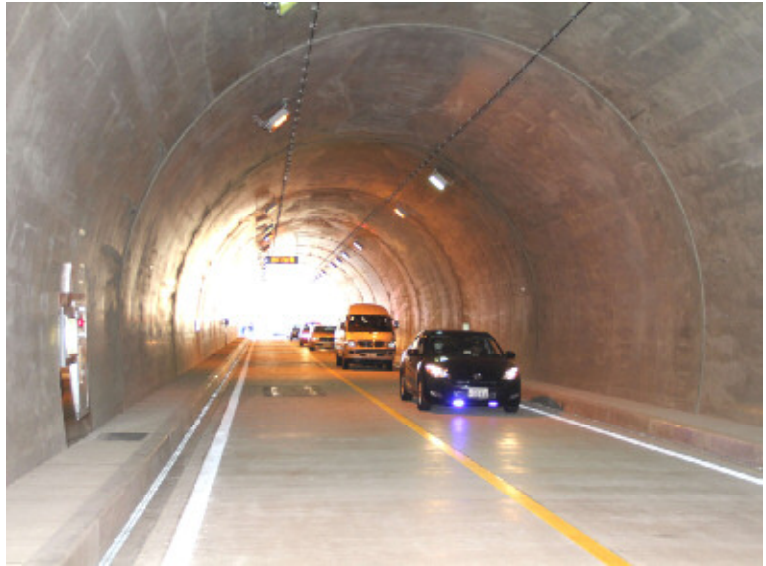
• ①地区連携軸の例：新天神トンネルの開通
