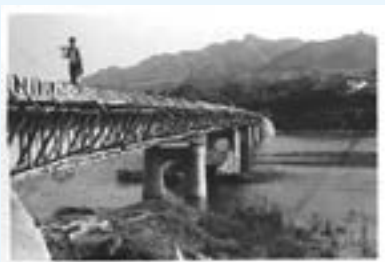
昭和34年当時の桂川橋
