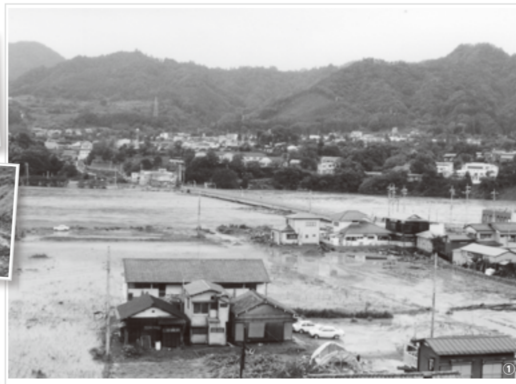
【57 災害】の被害の様子 昭和 57 年 8 月に日本各地に大きな災害の爪痕を残した台風 10 号、市内でも各地で土砂崩れや浸水の被害が発生しました。(写真①・② 桂川が氾濫した翌朝の島田地区新田と桂川橋、写真③大鶴地区大門の中央自動車道で土砂崩れが発生、④甲東地区棚頭で土砂崩れが起き民家が押し流された様子)
