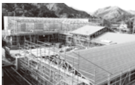
建設工事の様子 (11月19日現在)
