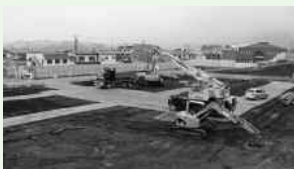
▲新市立病院完成に向け、着実に工事が進む建設予定地
