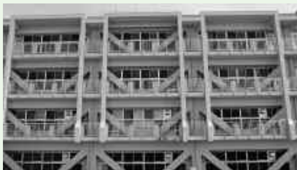
▲耐震補強が完了した上野原小学校
