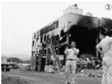
①気仙沼市の菅原茂市長（写真左）と江口市長（写真右）②気仙沼市役所で、震災の様子を話す菅原市長。③津波により鉄筋の骨組みと外壁だけが残った水産加工場。このあたりの漁港付近は火災なども発生し壊滅状態でした。④宮城県女川町の高台に立つ女川町立病院の駐車場から、津波にのまれ更地となった町内を見て愕然とする江口市長と市職員。津波は、江口市長が立っているこの場所まで上がってきたそうです。
