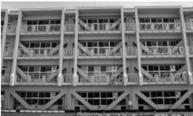
◆上野原小学校耐震補強事業
