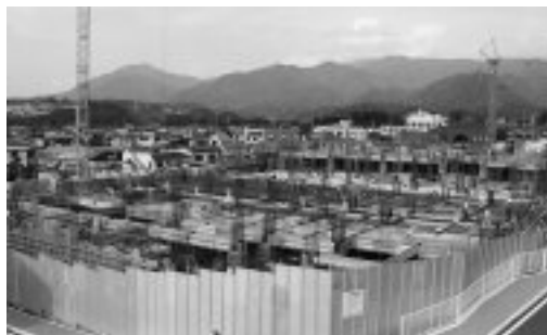
▲建設工事が進む新市立病院 (10月18日撮影)
