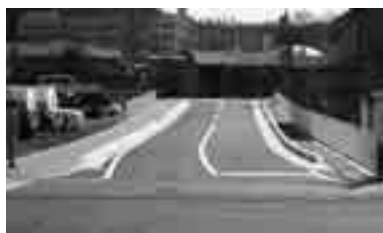
▲完成した市道大間々線
