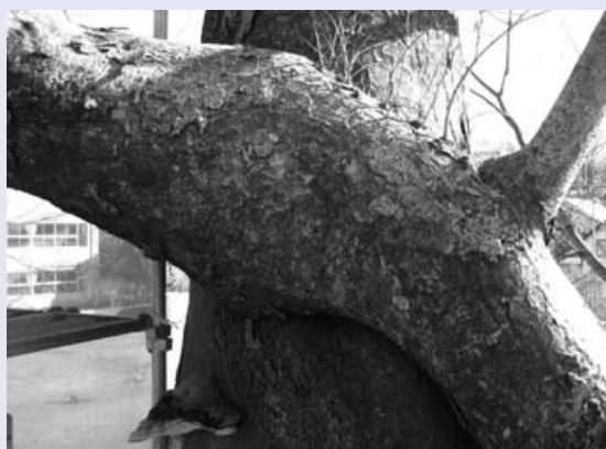
▲樹木医さんの話では、大枝が重なった部分は折れる心配があるそうです。安全のため枝を切って軽くし、支柱で補強する必要があります。
