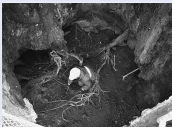
▲幹の空洞を覆っていたウレタンをはずし、通気を良くしました。内部の土は石やゴミが混じっていたので良質土に入れ替えました。
