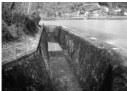
④調整池余水路
