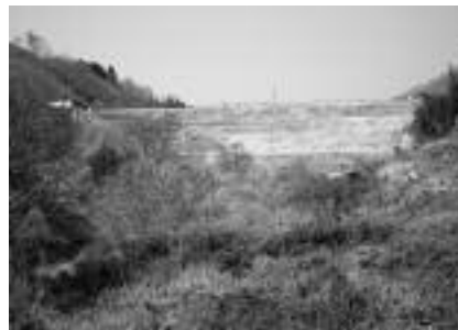
②調整池えん堤
