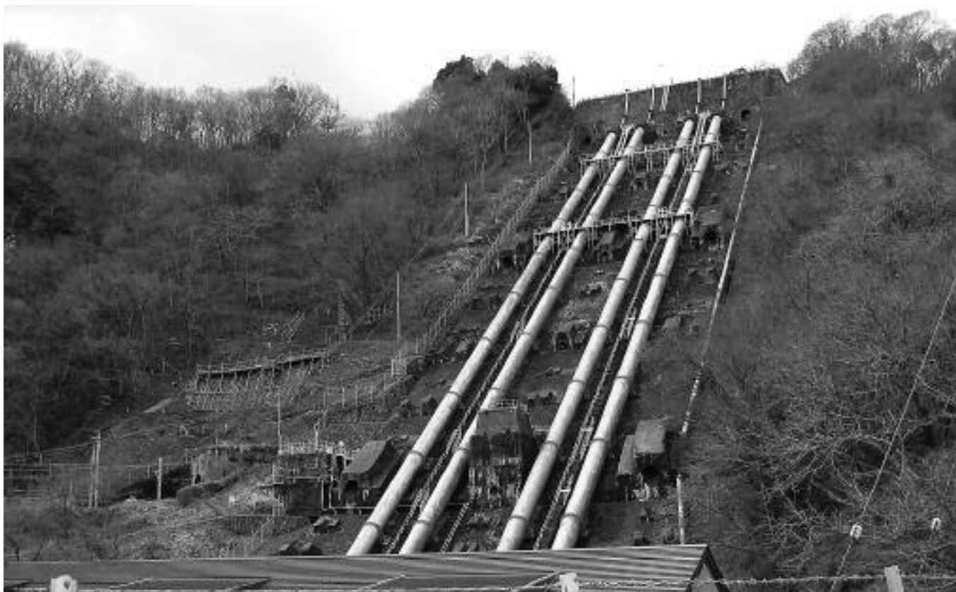
八ツ沢発電所（上野原市八ツ沢）写真にある送水管や手前の施設は未指定です。
