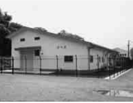
▲膜ろ過方式を採用しクリプトスポリジウム対策が図られた鶴島浄水場
