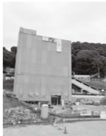
▲上野原駅南口昇降施設とその周辺 (5月24日撮影)
