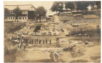
・月見ヶ池の工事風景(昭和6年竣工)
