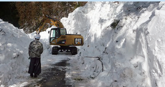
棚頭奥山地区の雪崩除去作業
