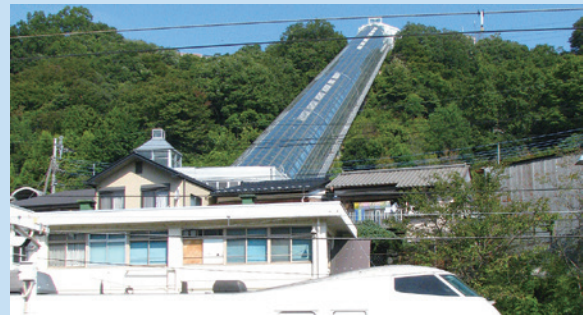
四方津駅舎との連結を待ち望むコモアブリッジ
