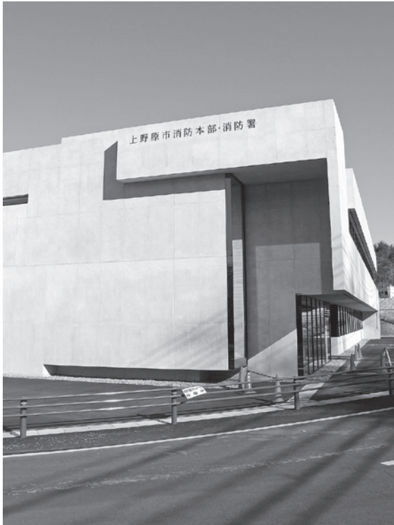
竣工が待たれる新消防庁舎
