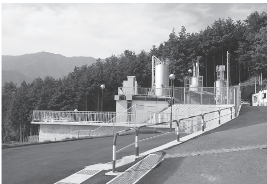
完成間近の秋山中部簡易水道配水池
