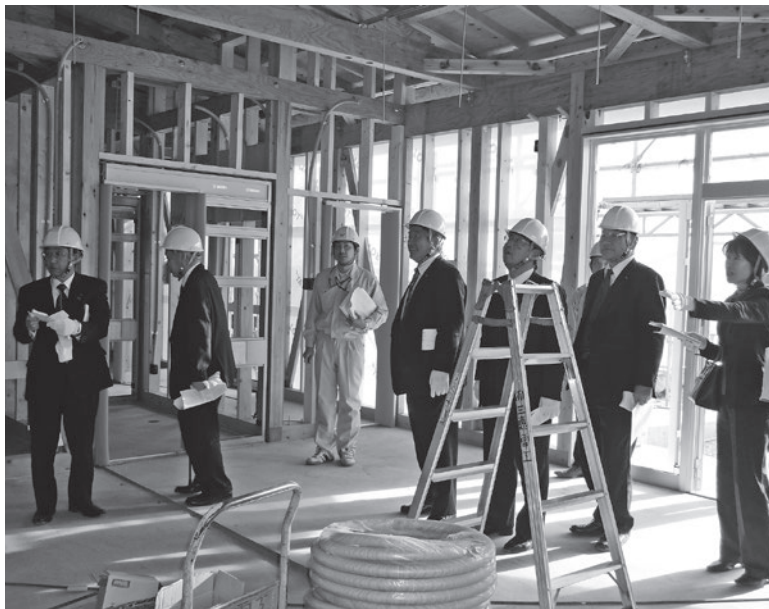
建設中の（仮称）新巖保育所の視察
