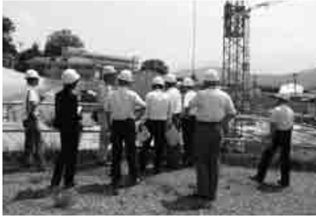
建設中の新市立病院
