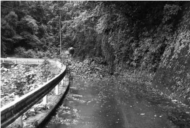
台風12号により崩落した市道小欄線
