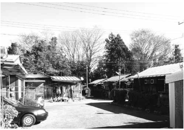
耐震化が望まれる市営住宅
