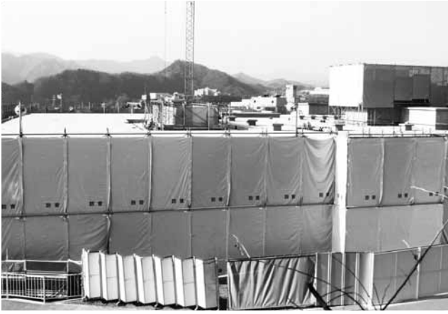
新病院建設の状況 (1月18日現在)
