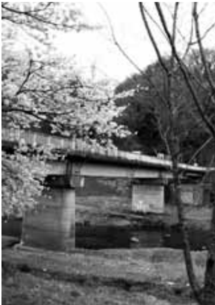
改良が望まれる鶴川橋
