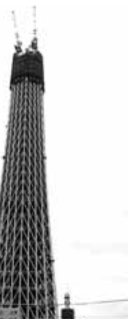
建設中の東京スカイツリー
