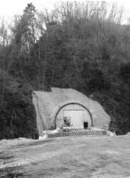
新天神トンネル（鶴島口）
