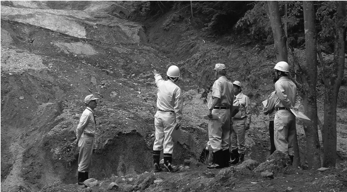
崩落現場の説明を受ける委員
