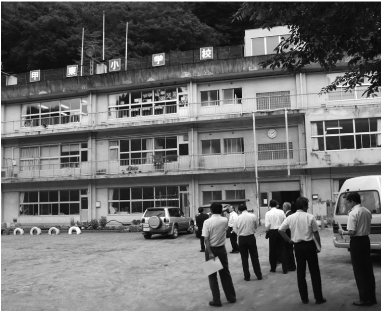
耐震強度不足が指摘される甲東小学校を視察
