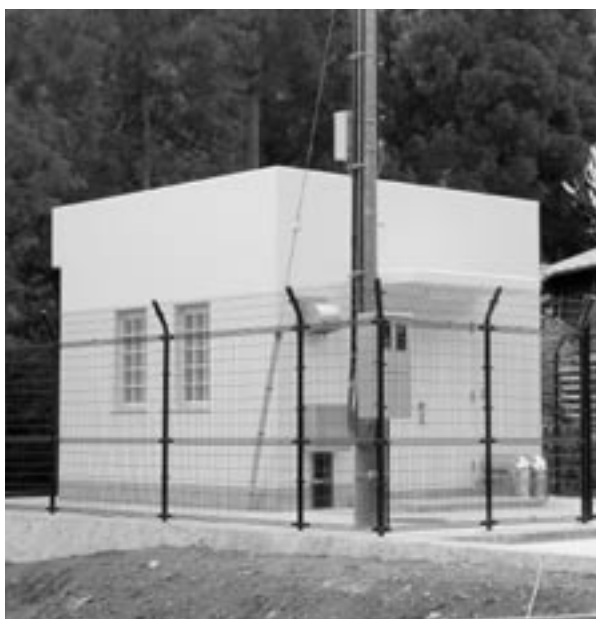
桑久保送水ポンプ場
