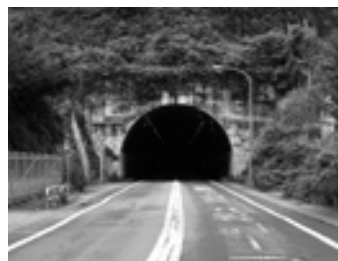
甲武トンネル
