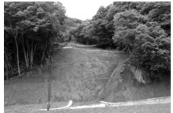
対策後の流失現場
