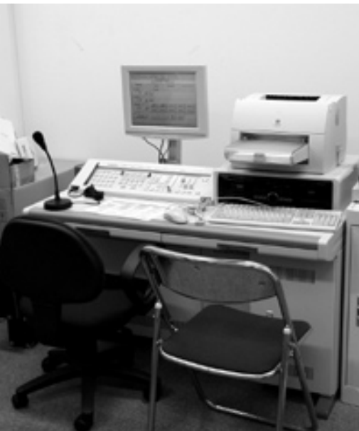
防災行政無線操作卓
