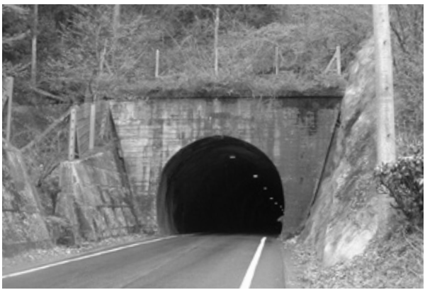
現在の天神トンネル
