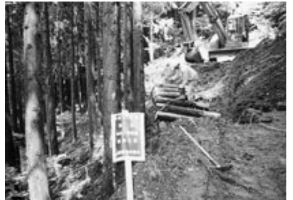
作業路の整備
