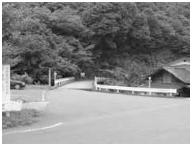
西部トンネルの入口（秋山側の予定地）
