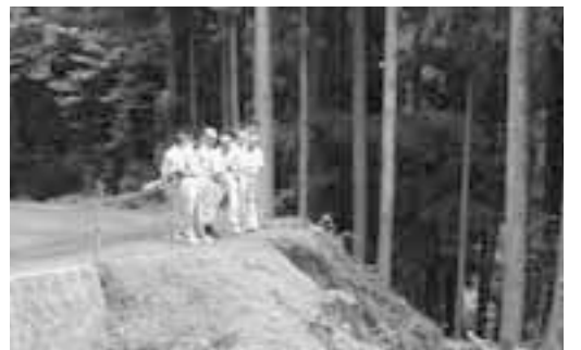
改良工事中の現場
