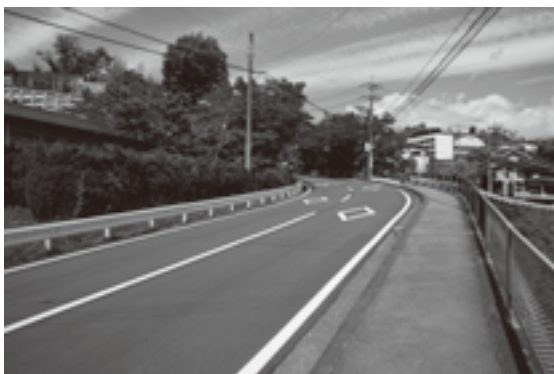
舗装改修工事を行った市道八ツ沢大柵線
