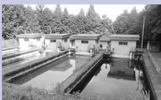
仲間川簡水浄水場
