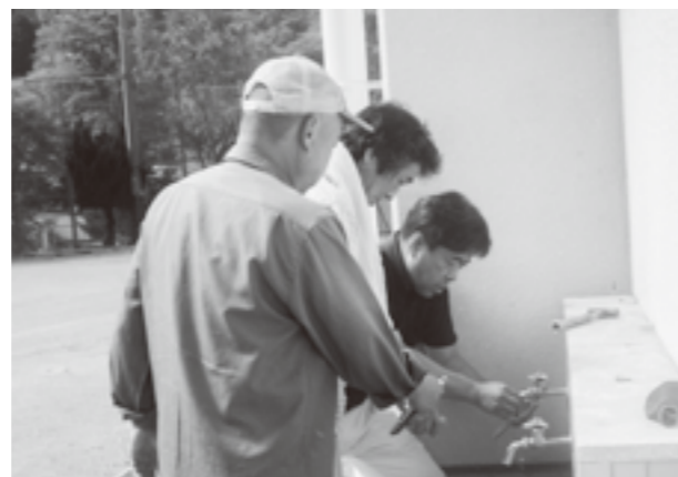
▼入念に点検・修理作業を行う上野原市上下水道組合のみなさん
