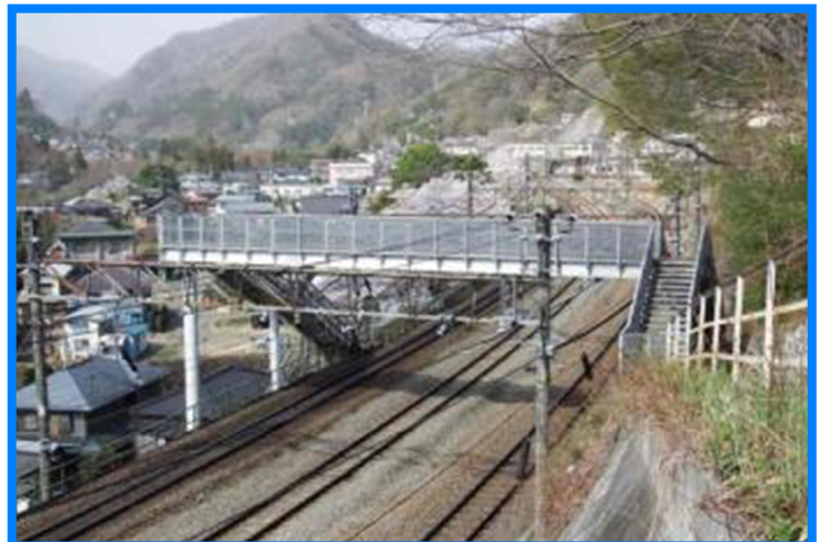
市道奥平東線 奥平陸橋
