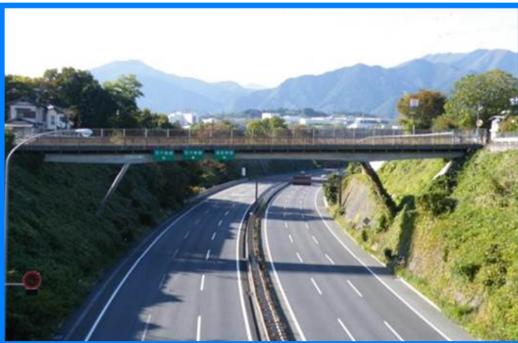
市道中央通り線 鳥居の前第2橋
