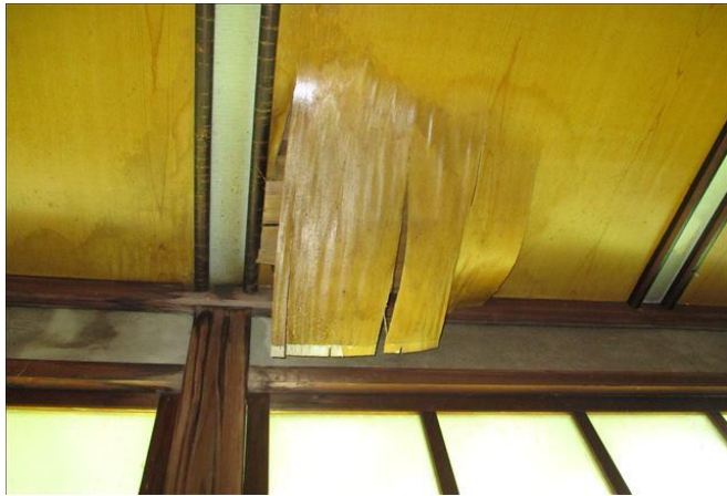
南側廊下天井
