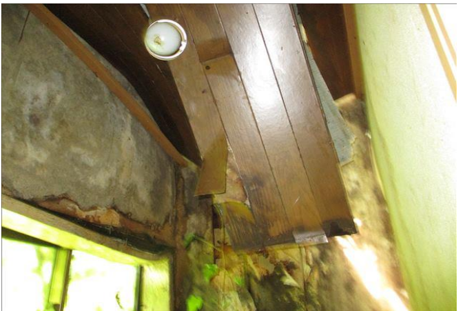
トイレ内天井
