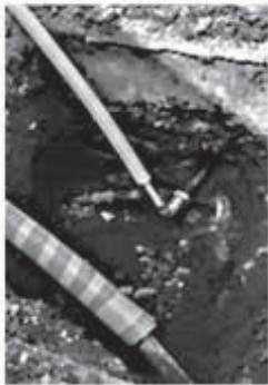
漏水管仮設工事
