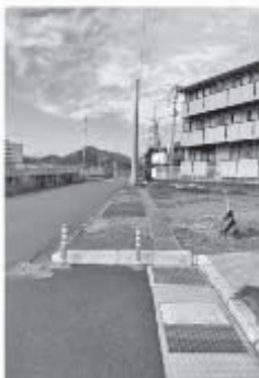
市道の狭あい箇所
