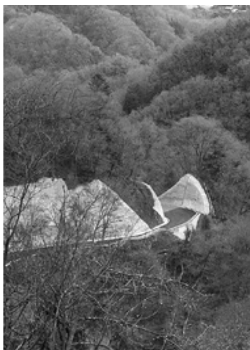
接続が要望されている富士東部林道(北線)
