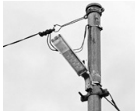
LED化された防犯灯
