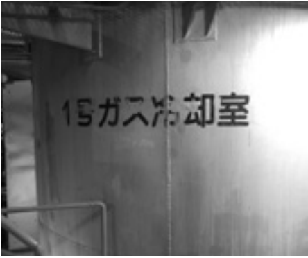
クリーンセンターの焼却施設
