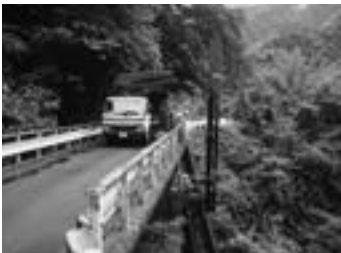
橋りょう点検車を使用し、作業員による近接点検を行います。
