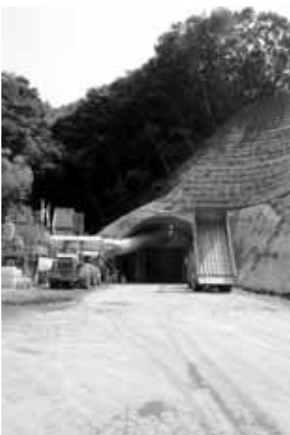
工事中新天神トンネル（田野入口）
