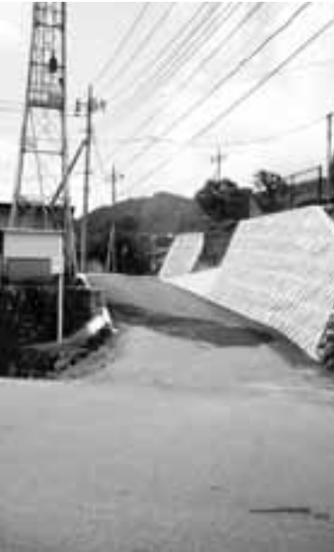
改修後の市道日原線
