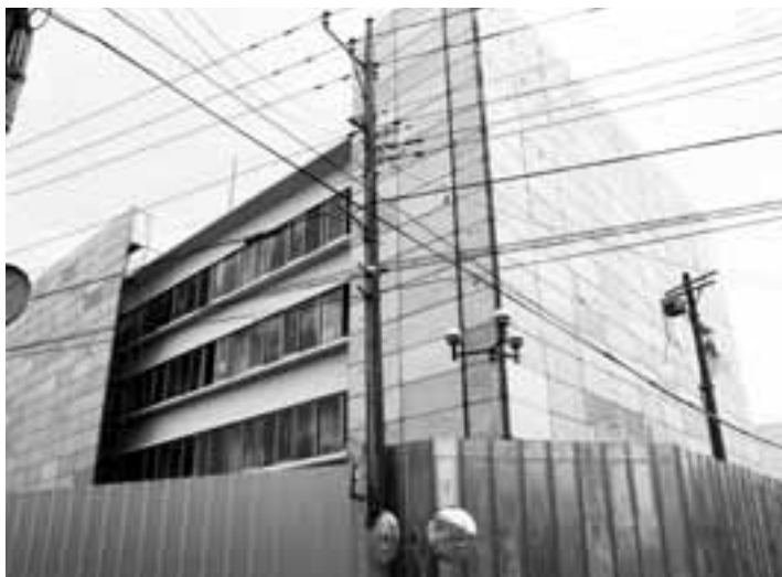
解体された市民会館
