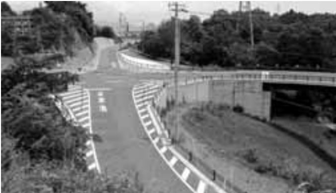
整備された県道平和橋
