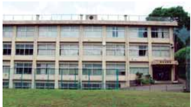
利活用が検討される旧桐原中学校
