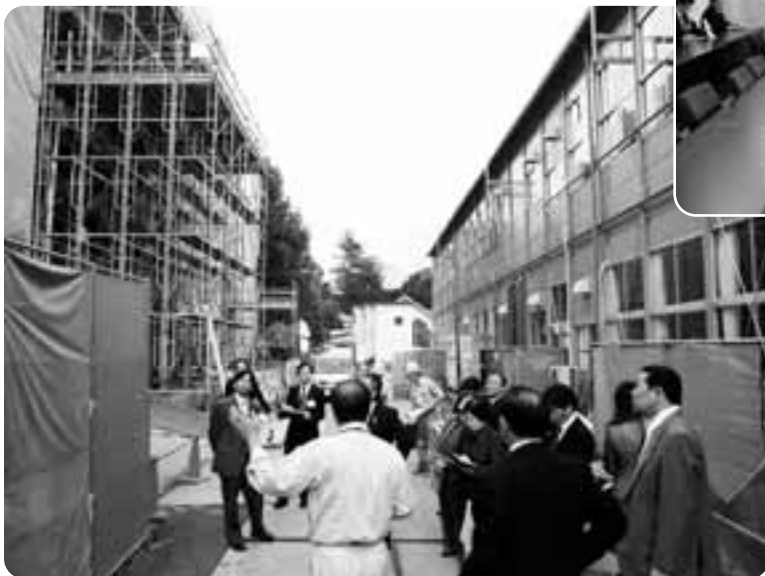
上野原小学校の耐震化工事を視察
