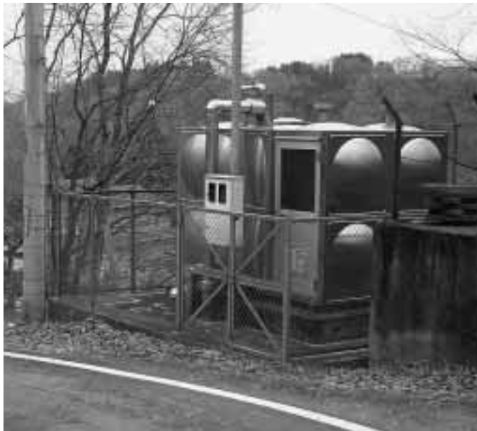
特定広域化施設整備が始まる大倉の配水池
